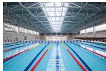
セントポールズ・アクアティックセンター
